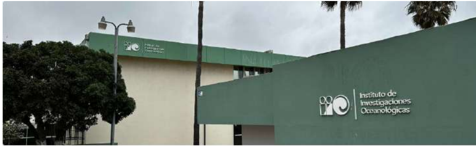
Mantenimiento, pintura y señalamiento de las instalaciones.
