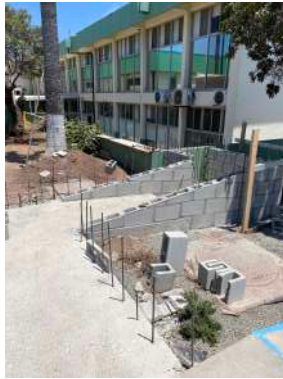
Inicio de construcción de la rampa de acceso universal al segundo piso del edificio Katsuo Nishikawa y trabajos de jardinería en el principal acceso al andador costero.
